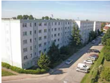
Im Überblick: die Wohnblöcke Am Stadion 4 -15.
