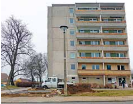
Schon im Bau: Die Stellflächenanlage für die neuen umweltfreundlichen Müllcontainer
