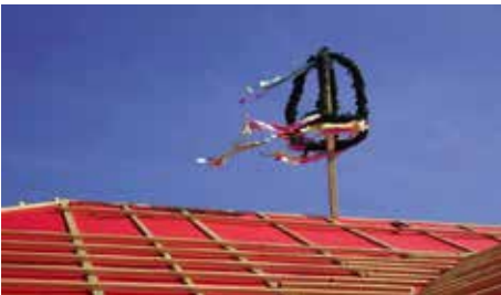
Gut geschafft: Über den Neubauten Frankfurter Straße 22 wehte am 26. September die Richtkrone. Bezug der Häuser im Sommer 2017.
